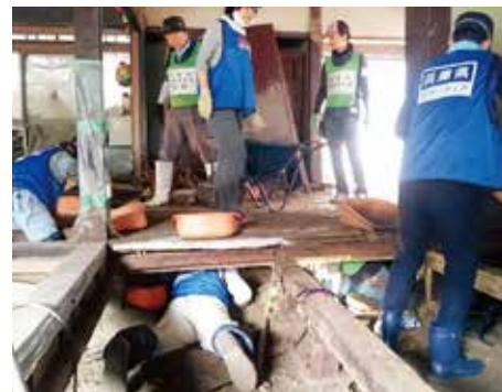
福岡県朝倉市 個人宅にて床下の泥出し作業
