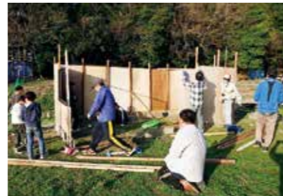
「冒険広場遊び村」の建設の様子
