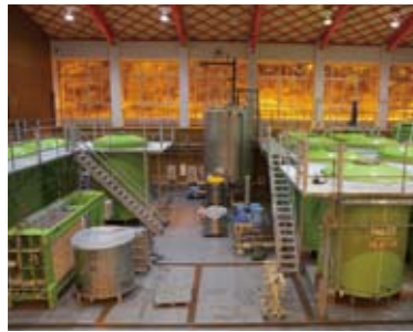
体育館には大型の貯蔵タンクが並ぶ
